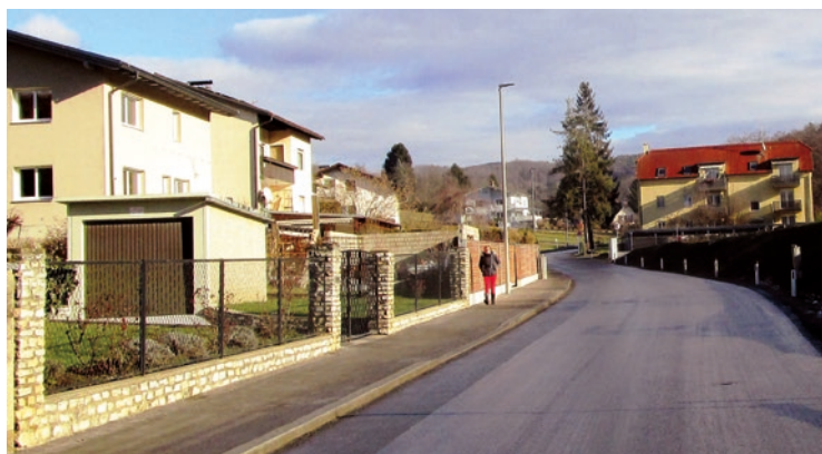
Ziegelstraße: Gehsteig wird verlängert.
