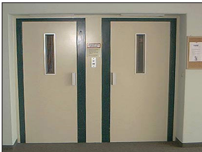
Steirisches Gesetz macht alte, aber sichere Lifte zur teuren Kostenfalle.
