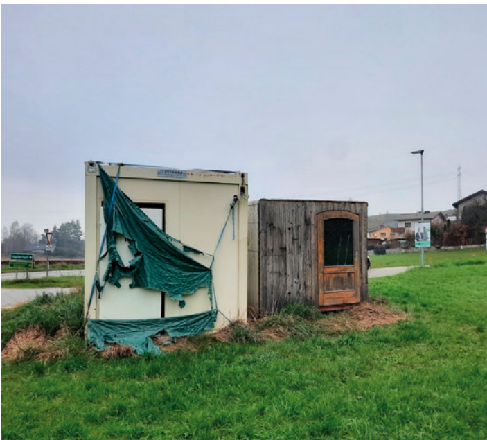
Wann wird der Schandfleck in der Ortseinfahrt endlich entfernt?
